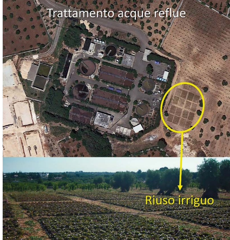
Impianto di depurazione di Castellana Grotte (BA) adiacente a un campo sperimentale per il riuso delle acque reflue affinate.
